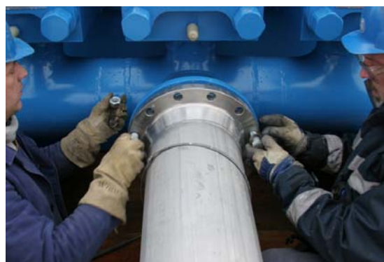
Bild 9: Druckleitungsmontage an Pumpe
