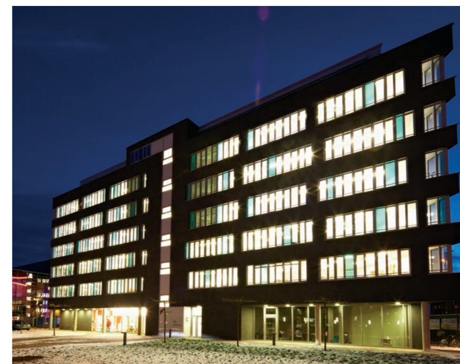
PortAL 10, Büro- und Ärztehaus in Münster (Quelle: HOCHTIEF Projektentwicklung GmbH)
