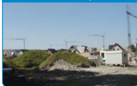
Bebauungsplangebiet im Juli 2003. Die Häuser sind in der Rohbauphase.
